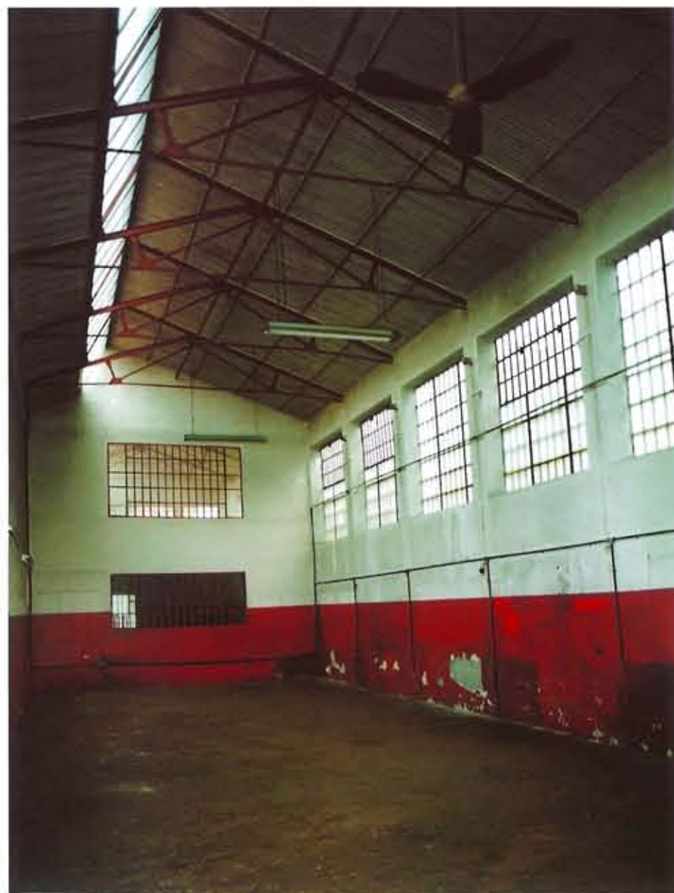
Veduta dell'esterno e dell'interno dell'edificio prima dell'intervento
